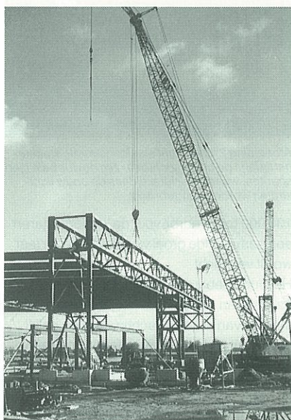
Afbeelding 5. Montage 1e hoofdlijger, de overspanning bedraagt 2 \times 33 \text{ m}
